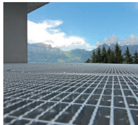
Für die ganzjährige Begehung wurde ein Sprich Pressrost mit einer Maschenweite von 33 × 11 mm gewählt.
